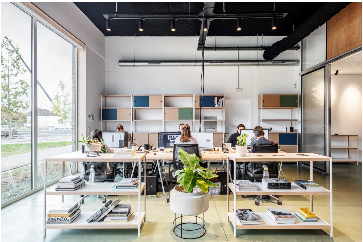
Beeld kantoor met technische kanalen en leidingen in het zicht tegen het plafond
